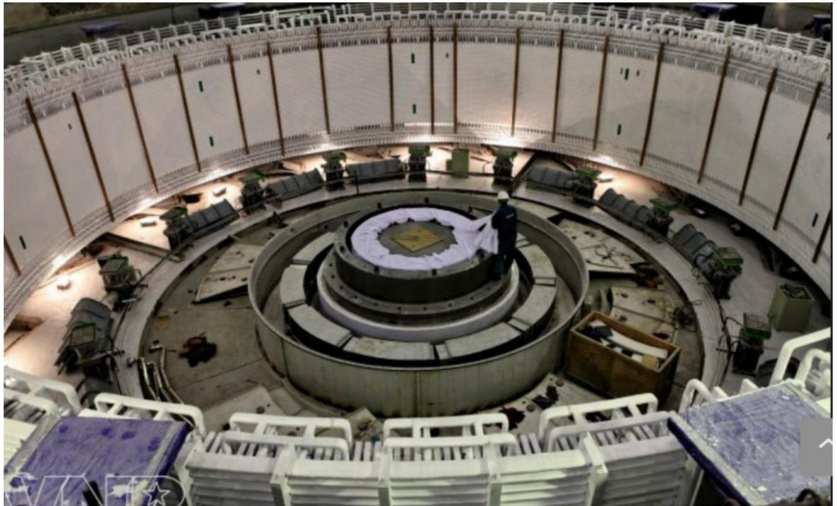
stator d'un alternateur de centrale hydraulique
