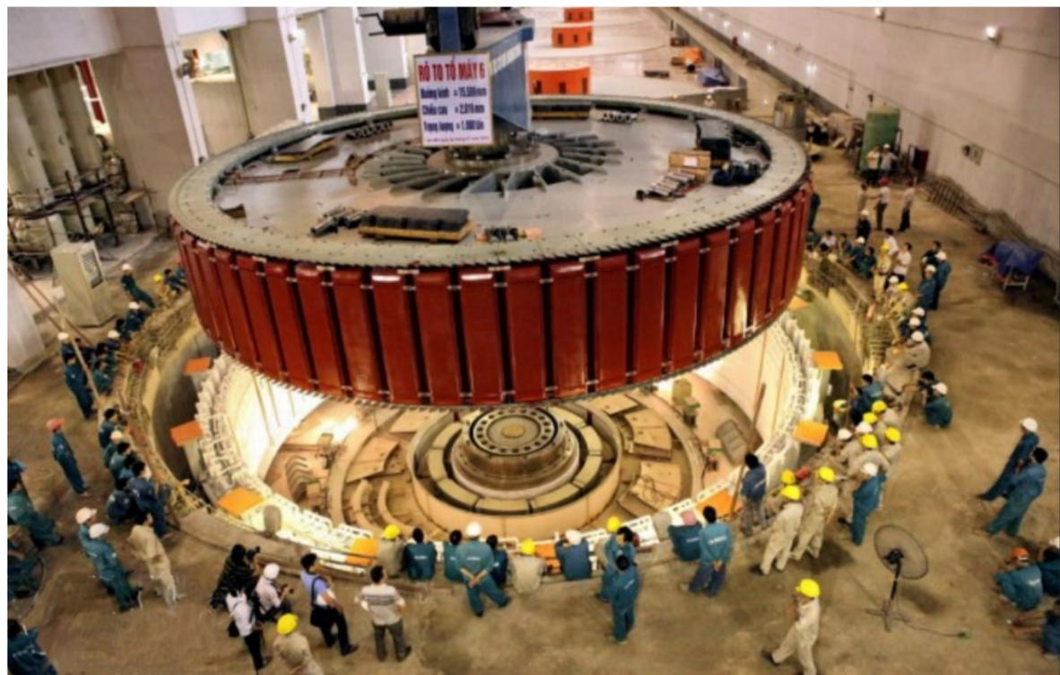
rotor d'un alternateur de centrale hydraulique
