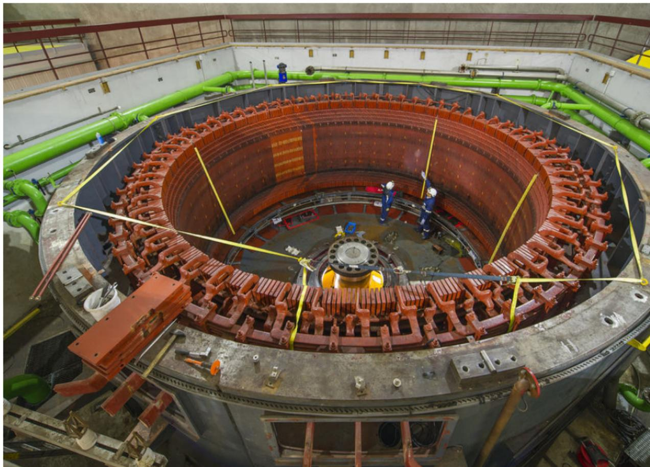
stator d'un alternateur de centrale hydraulique
