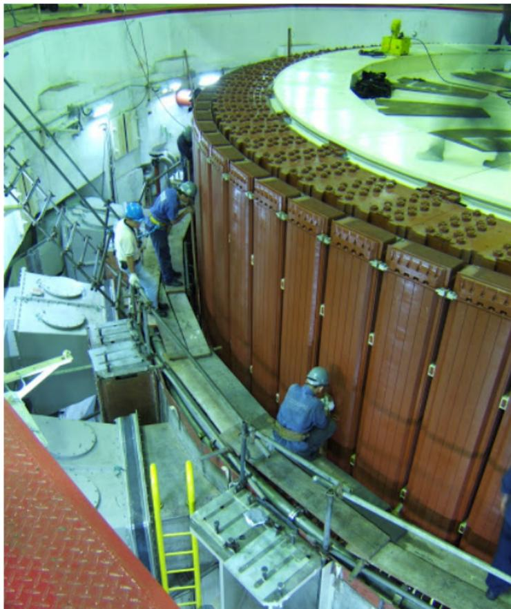
pôles du rotor d'un alternateur de centrale hydraulique
