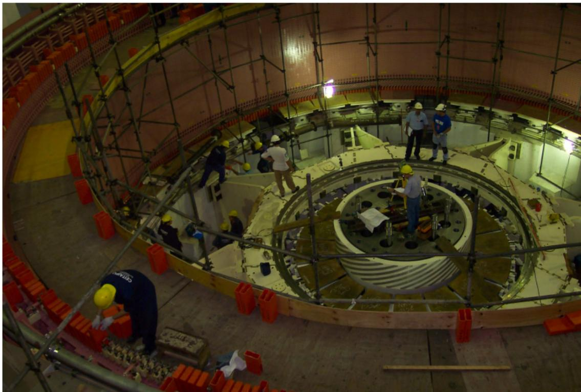
stator d'un alternateur de centrale hydraulique
