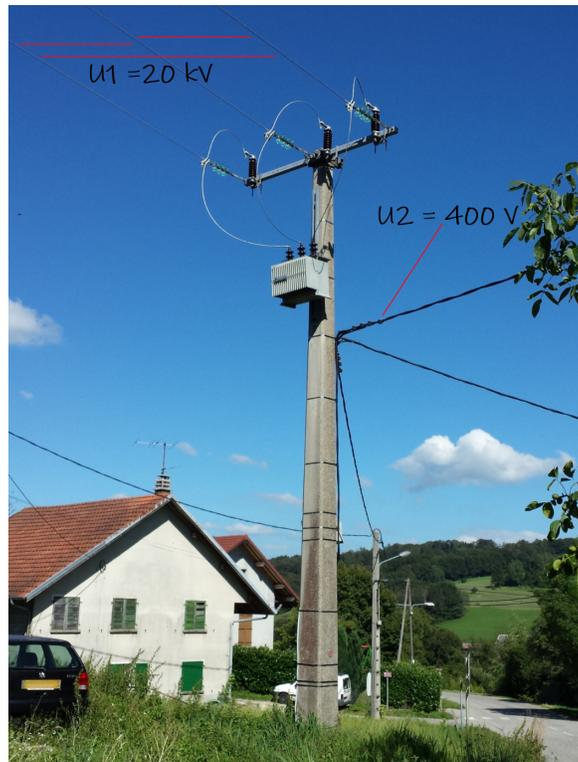
FIGURE 3: Transformateur « terminal » 20 kV/400 V pour l'alimentation des installations domestiques ( $S \leq 100 \text{ kVA}$ ).
